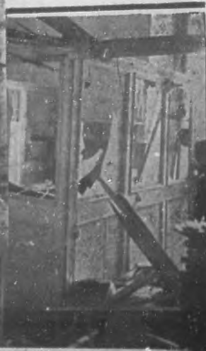
Estado en que quedó el Departamento de Higiene Infantil y otros anexos, que estaban instalados en el piso bajo de la Secretaría de Sanidad, próximo al lugar donde explotó la bomba colocada en la parte posterior del edificio.—(Foto de Vales.)
